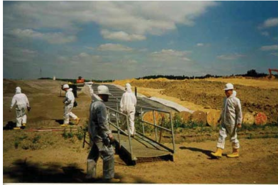
Foto 1: Toegang tot stortcompartiment in afwerking. Zichtbaar zijn de HDPE-folie, de drainage-mat en de drainage- en afwerklaag
