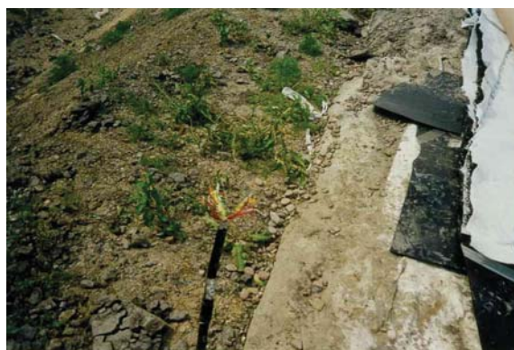
Foto 6: 20-Aderige kabel van het Geologgersysteem
