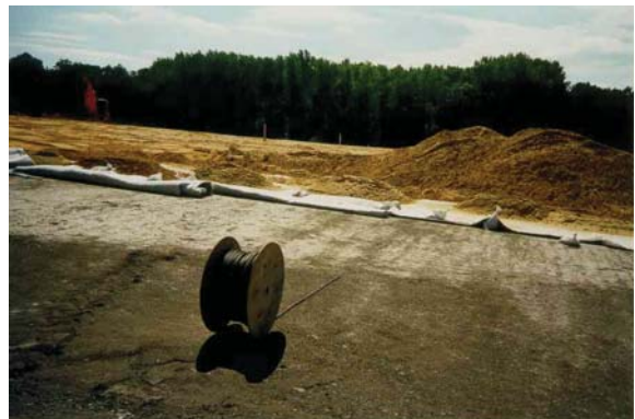
Foto 2: De diverse rollen met kabels voor het Geologger-systeem zijn zichtbaar
