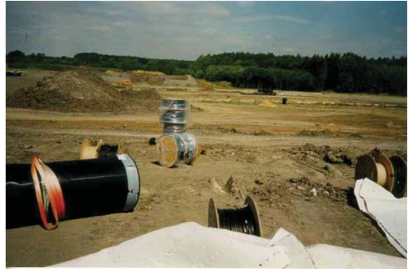
Foto 2: De diverse rollen met kabels voor het Geologger-systeem zijn zichtbaar
