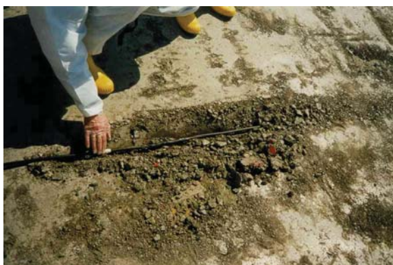
Foto 5: Kabel die is aangebracht in de steunlaag en waar te zijner tijd de kunststoffolie overheen komt
